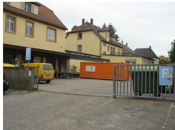
Foto 24: Rückwärtiger Bereich "Alte Post"
