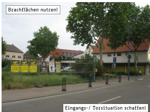
Foto 29: Brachflächen Obere Hauptstraße
